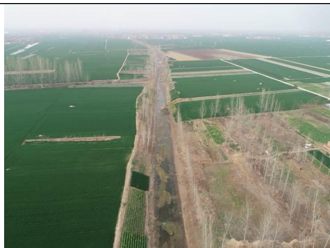
沱河治理起点处河道现状—航拍图 3
