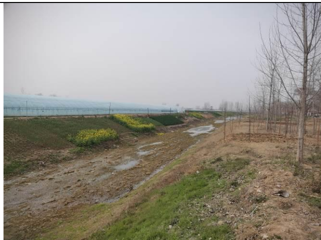
河道治理工程—现状
