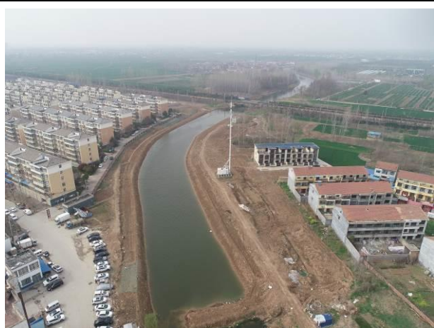
沱河治理跨铁路处（终点）河道—航拍图 1
