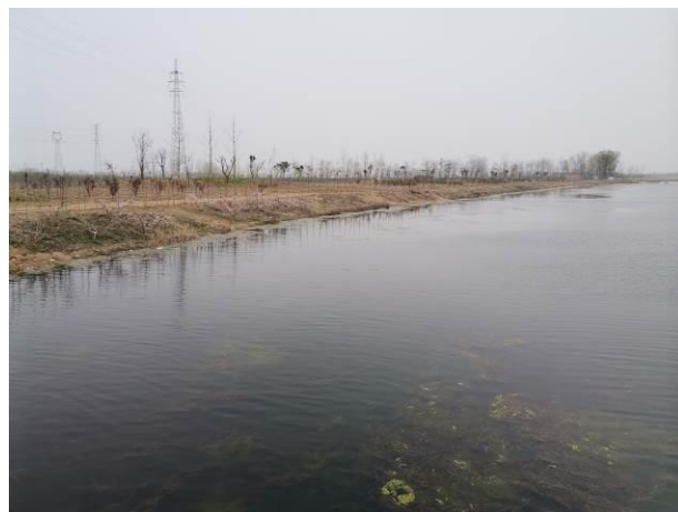
河道治理工程—现状
