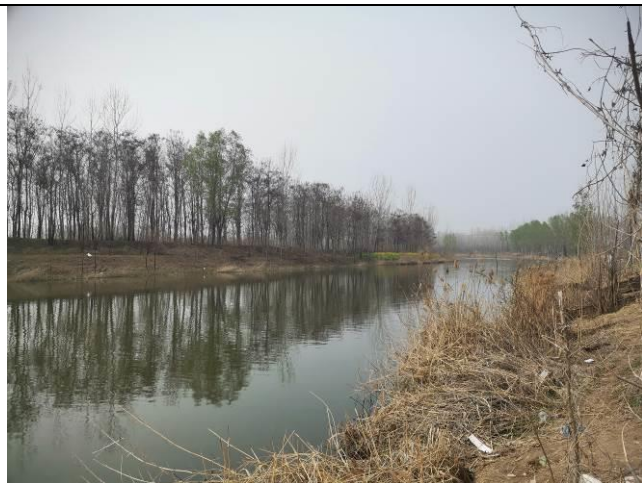
河道治理工程—现状
