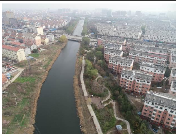
沱河治理跨铁路处（终点）河道—航拍图 2
