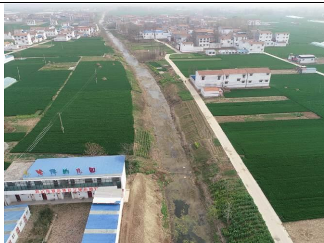
沱河治理起点处河道现状—航拍图 1
