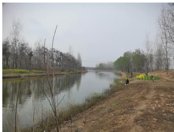
河道治理工程—现状
