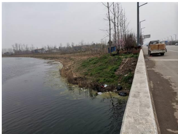
河道治理工程—建筑物现状
