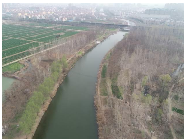
沱河治理跨铁路处（终点）河道—航拍图 3
