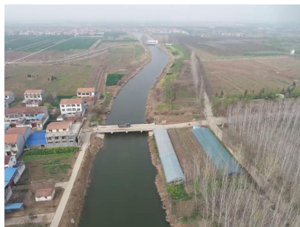
沱河治理跨铁路处（终点）河道—航拍图 4
