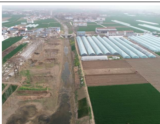
沱河治理起点处河道现状—航拍图 4
