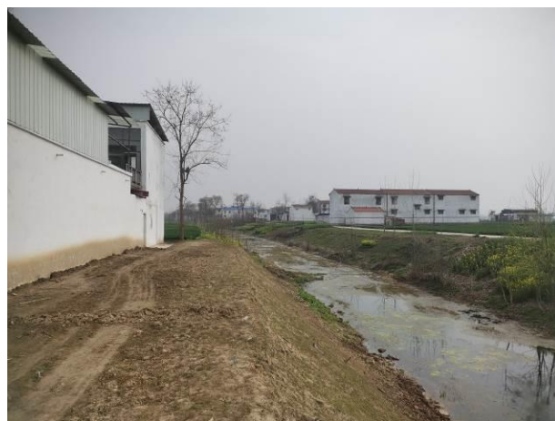
河道治理工程—建筑物现状
