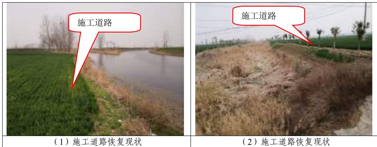
图 1-3 施工道路恢复现状影像图
